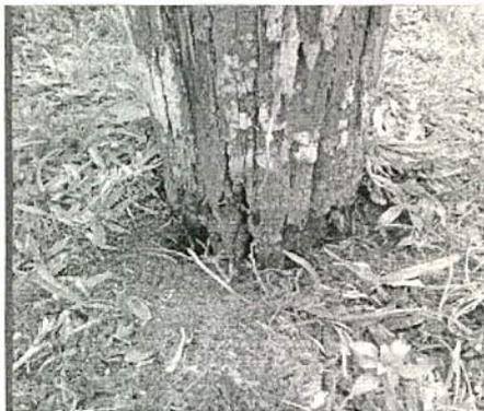
Faz-se necessária a substituição do poste, pois o mesmo está deteriorado pela ação do tempo em eminência de cair; e a instalação de luminária é urgente, uma vez que o local encontra-se em total escuridão, o que causa insegurança aos moradores
