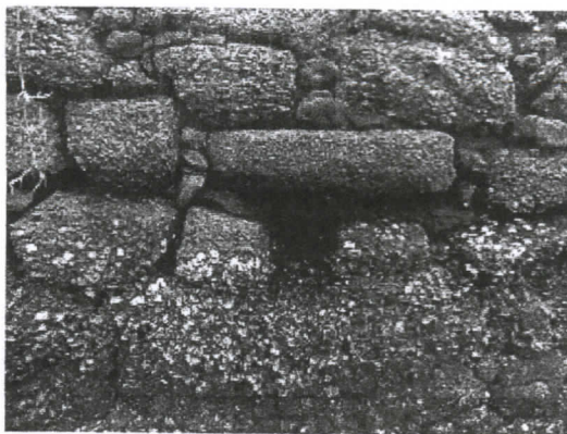
Figura 4. Cano com saída para a praia, no muro de pedras.
