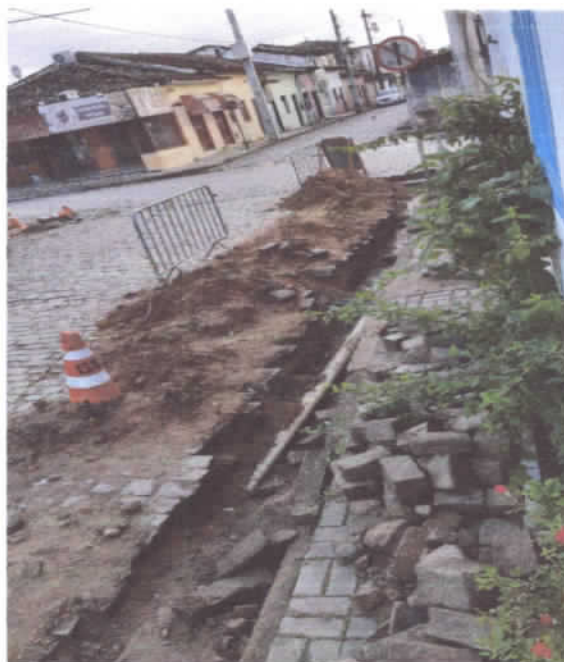
Foto da obra em 2020
