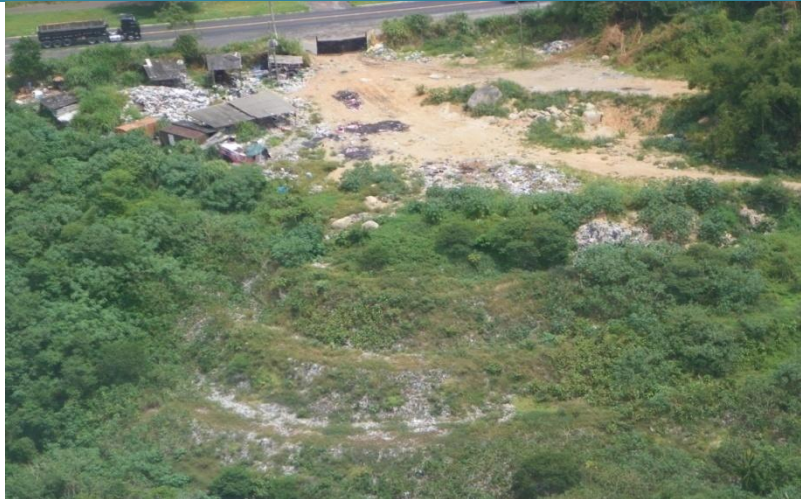
Figura 25 - Resíduos expostos pela erosão dos taludes
