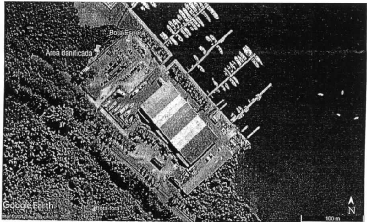
Figura 1: Imagem Google Earth pro com a localização da área de manguezal que sofre danos decorrentes do empreendimento - polígono em vermelho e os pontos de localização do "bota-espera" e "bota-fora".
